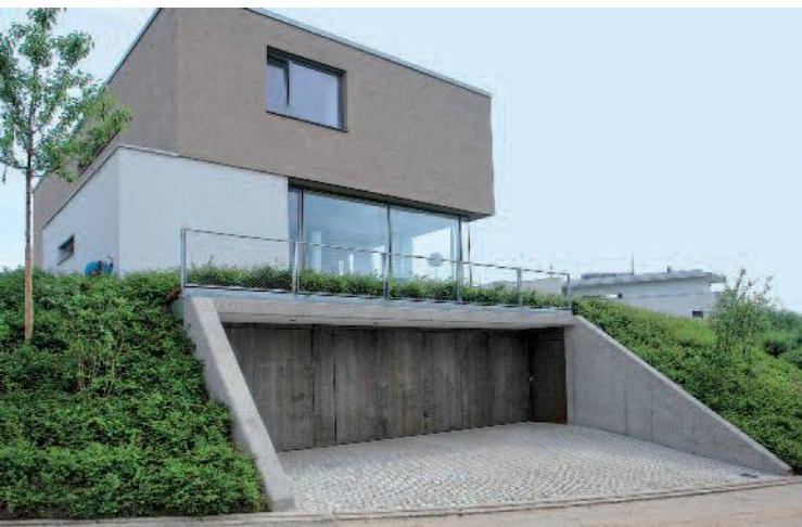
Kipptor bauseitig mit Cortenstahl verkleidet
