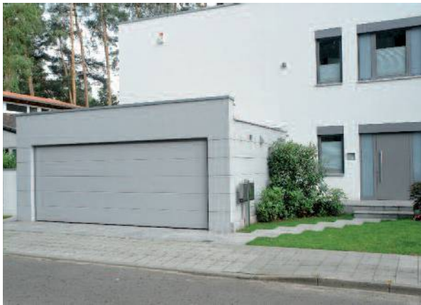
Durchgehende Linienführung bei Kiptor und Garage
